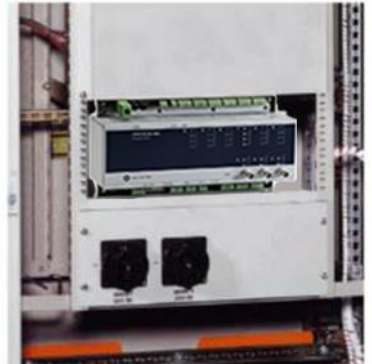
Abbildung 4 Installation des Schaltschranks in einem sicheren Bereich
